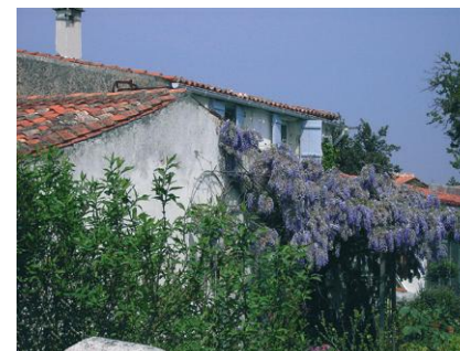
Les treilles ou glycines utilisées en protection d'été des façades sud, Marennes
