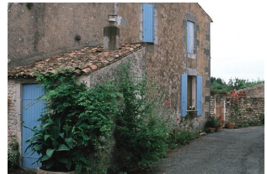
Habitation enduite, murs et dépendances en moellons apparents, Souhe, Le Gua
