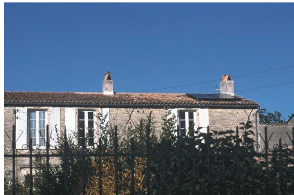
Capteurs solaires sur toiture ancienne
