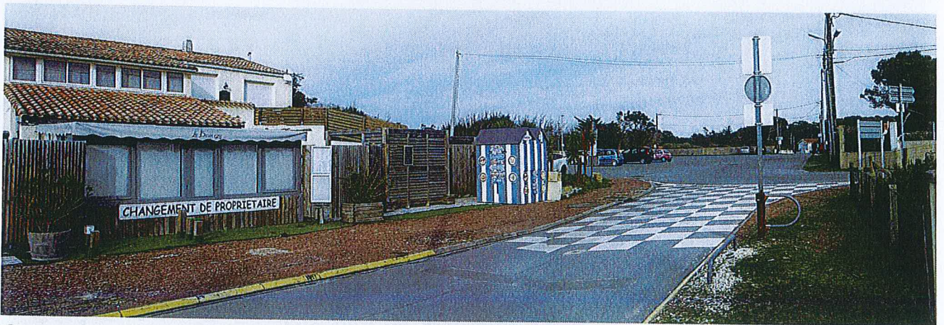
Connexion entre la rue du cannot de sauvetage et le parking
